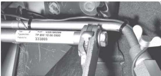
Verlegung des Massekabels zum Gaspedal
